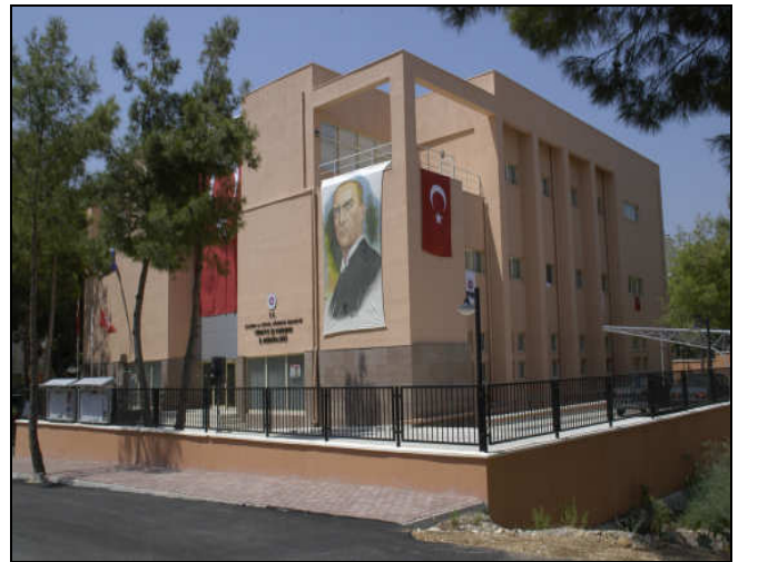
Antalya İl Müdürlüğü Hizmet Binası
